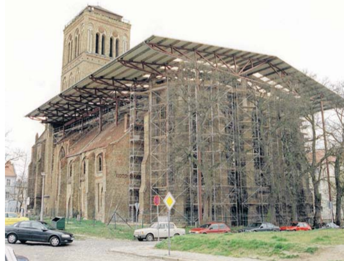
Der Wiederaufbau der Nikolaikirche begann Mitte der 90er Jahre. Hier mit dem provisorischen Dach.
